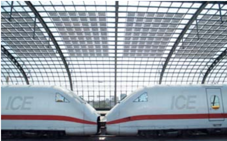
Berlin Lehrter Bahnhof, Solarmodule im Dach integriert, Foto BSW
