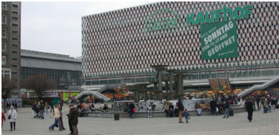
Berlin Alexanderplatz alte Alufassade
