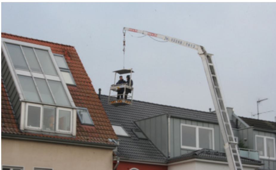
Sichtprüfung mit Kontrollkorb
