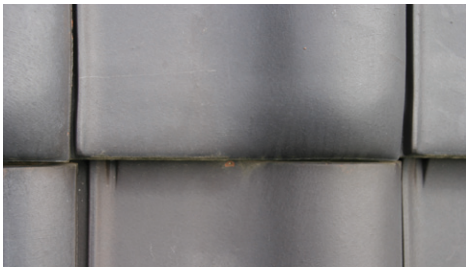
Absprengung durch Fremdpartikel an Tondachziegel
