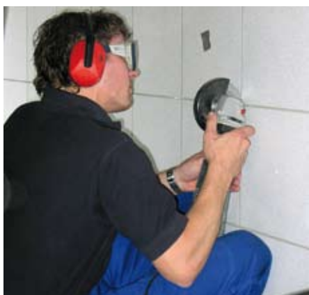
Ein Munters-Mitarbeiter löst eine Fliese
