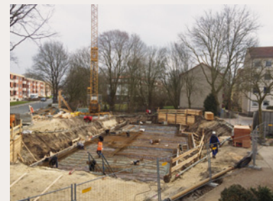
Die Baustelle vor dem Betonieren der Sohle im März 2016.
