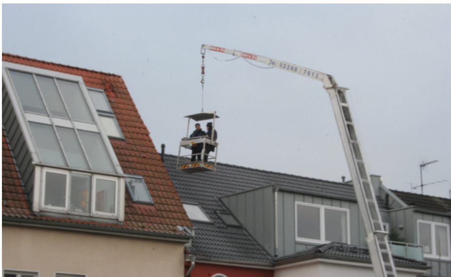
Sichtprüfung mit Kontrollkorb
