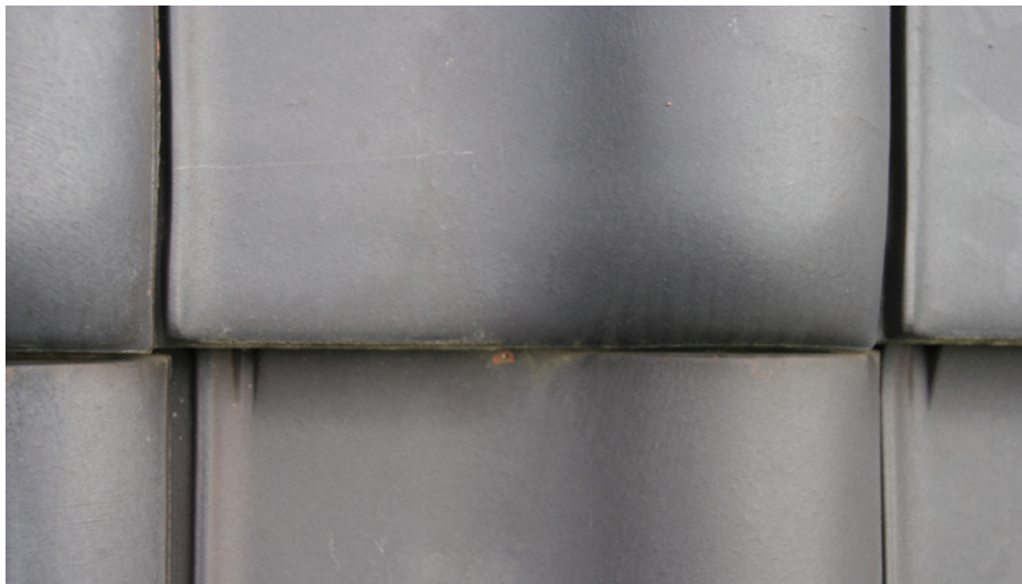
Abspaltung durch Fremdpartikel an Tondachziegel
