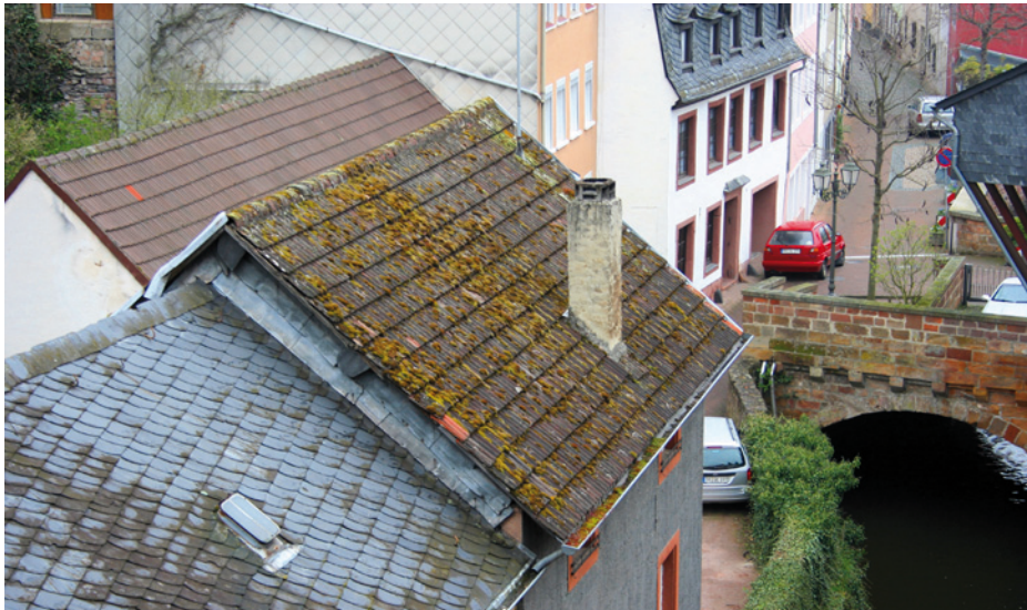
Moosbildung auf nassen Betondachsteinen und Moselschiefer
