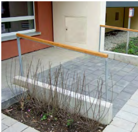
Barrierearmer Zugang ins Wohnhaus.
