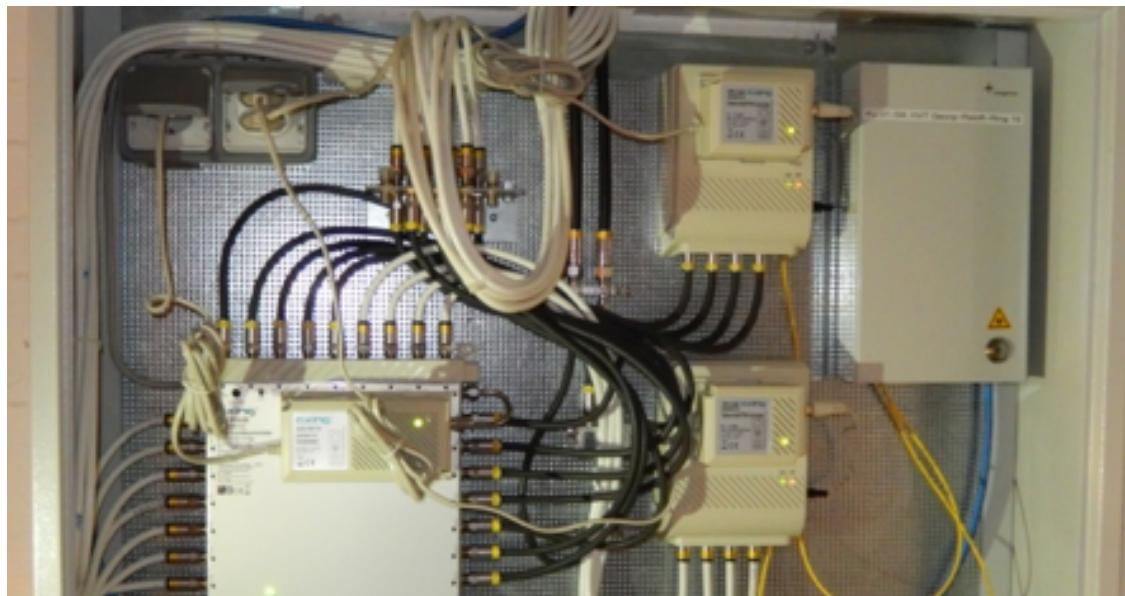
Zusammenführung von SAT und Kabelanschluss Foto Buchholz
