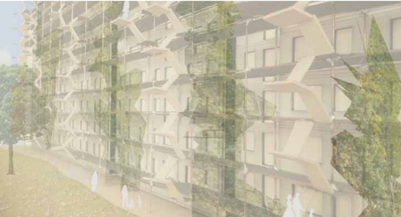
Perspektive auf die den bestehenden Plattenbauten vorgesetzten Laubengänge
