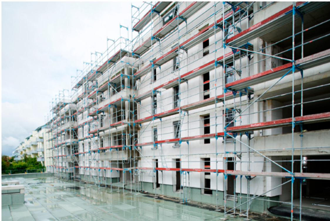
Rohbauarbeiten an der Graf-Stauffenberg-Straße in Oberreut. Quelle: L-Bank / Wagenhan
